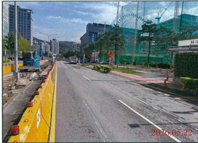
巡查日期地點：115.05.22/ 尾軌 照片說明：路面狀況
