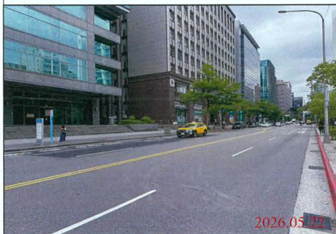
巡查日期地點：115.05.22/ Y31車站 照片說明：路面狀況
