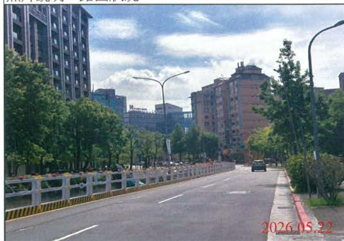
巡查日期地點：115.05.22/ Y30車站 照片說明：路面狀況
