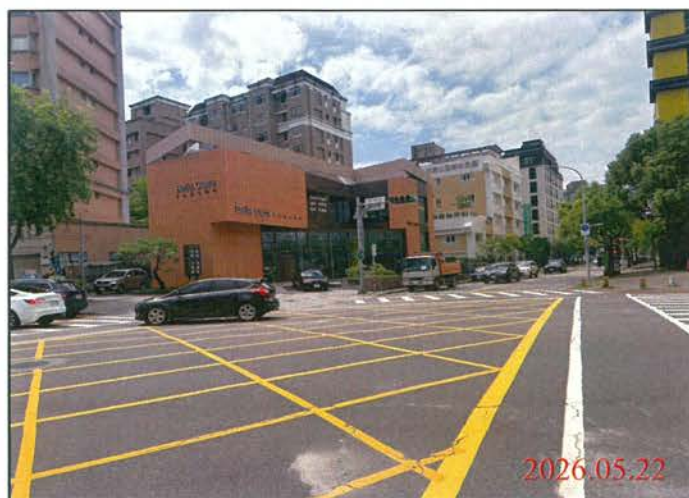
巡查日期地點：115.05.22/ Y30車站 照片說明：路面狀況
