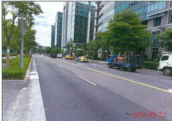
巡查日期地點：115.05.22/ Y32車站 照片說明：路面狀況
