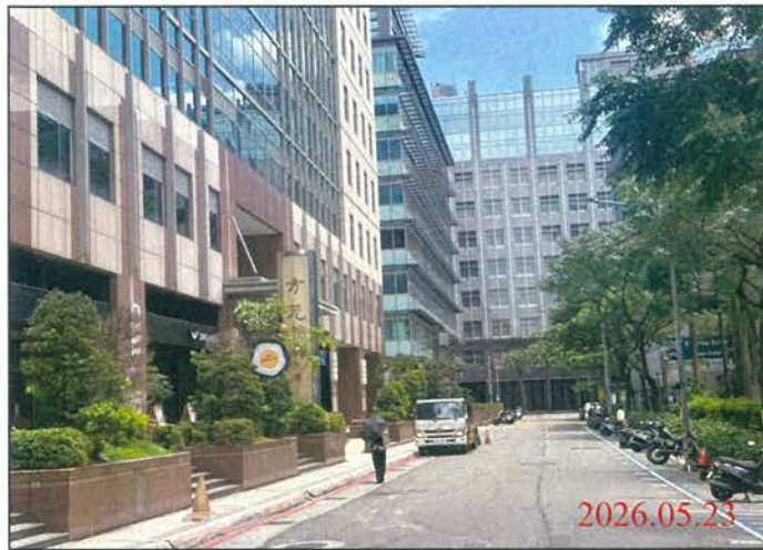
巡查日期地點：115.05.23/ Y31車站 照片說明：路面狀況
