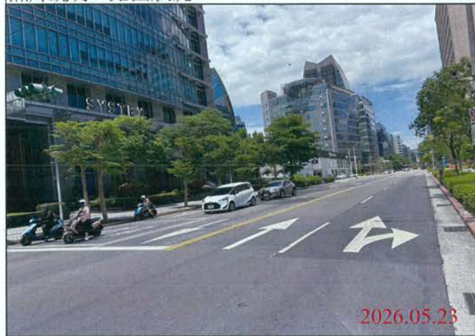
巡查日期地點：115.05.23/ Y32車站 照片說明：路面狀況
