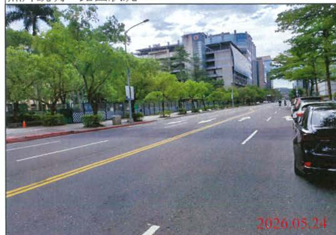
巡查日期地點：115.05.24/ Y31車站 照片說明：路面狀況
