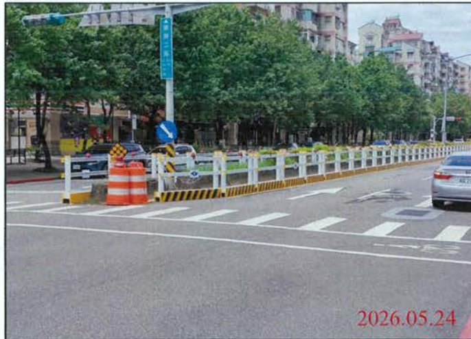
巡查日期地點：115.05.24/ Y30車站 照片說明：路面狀況
