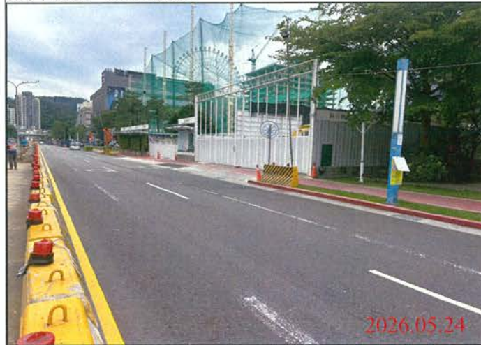
巡查日期地點：115.05.24/ 尾軌 照片說明：路面狀況
