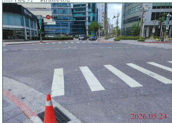
巡查日期地點：115.05.24/ Y32車站 照片說明：路面狀況
