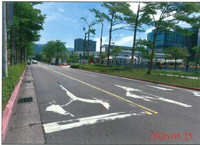
巡查日期地點：115.05.25/ Y32車站 照片說明：路面狀況
