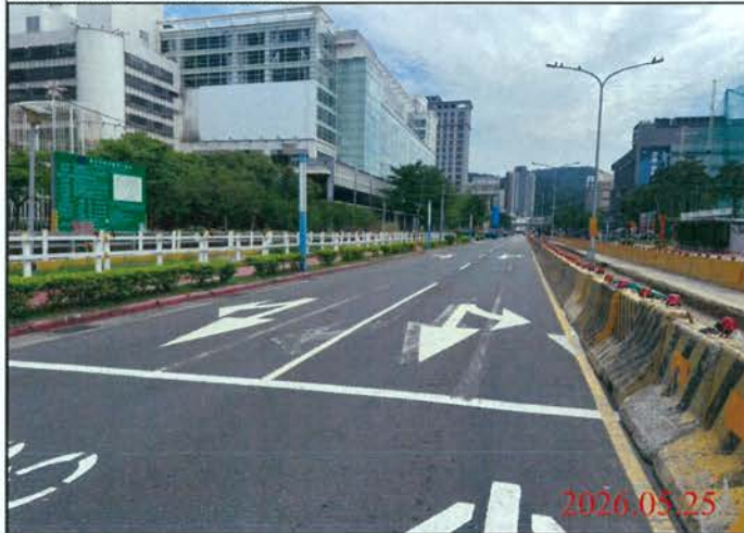
巡查日期地點：115.05.25/ 尾軌 照片說明：路面狀況
