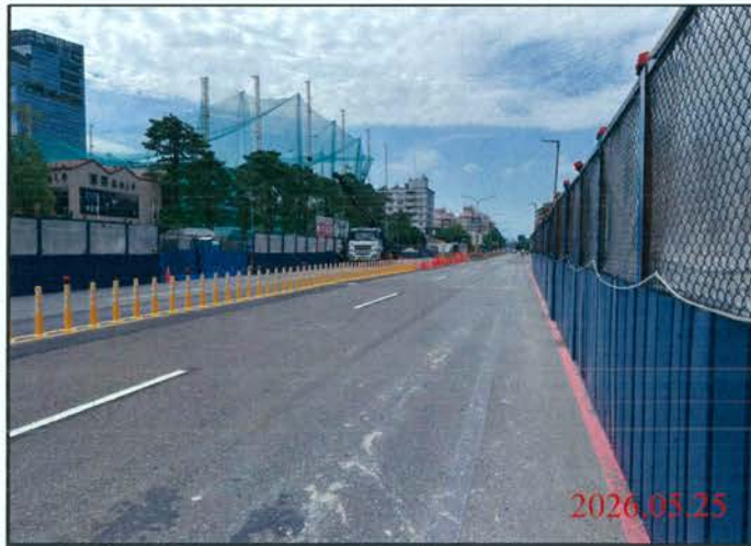
巡查日期地點：115.05.25/ 尾軌 照片說明：路面狀況
