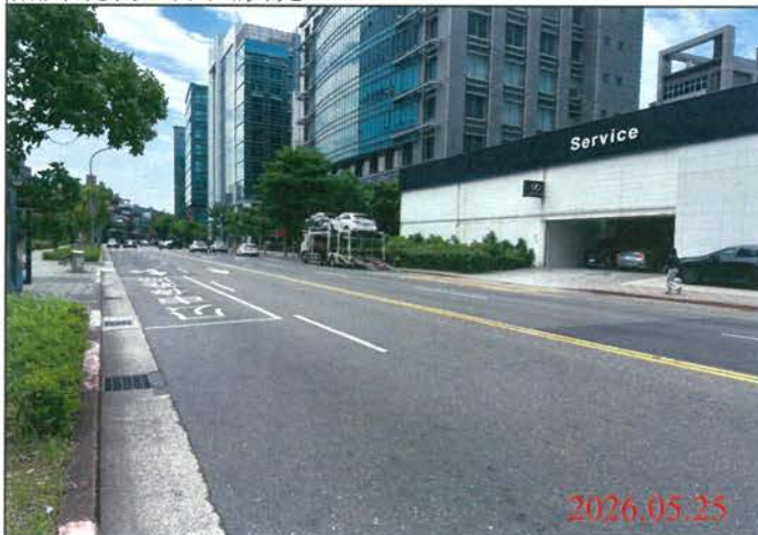
巡查日期地點：115.05.25/ Y32車站 照片說明：路面狀況
