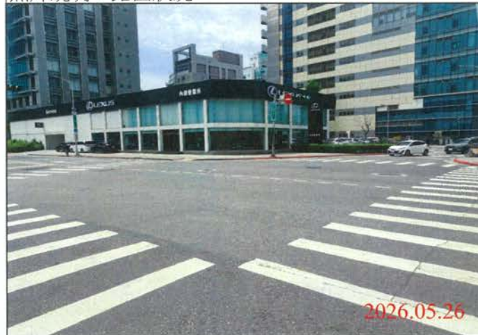
巡查日期地點：115.05.26/ Y32車站 照片說明：路面狀況
