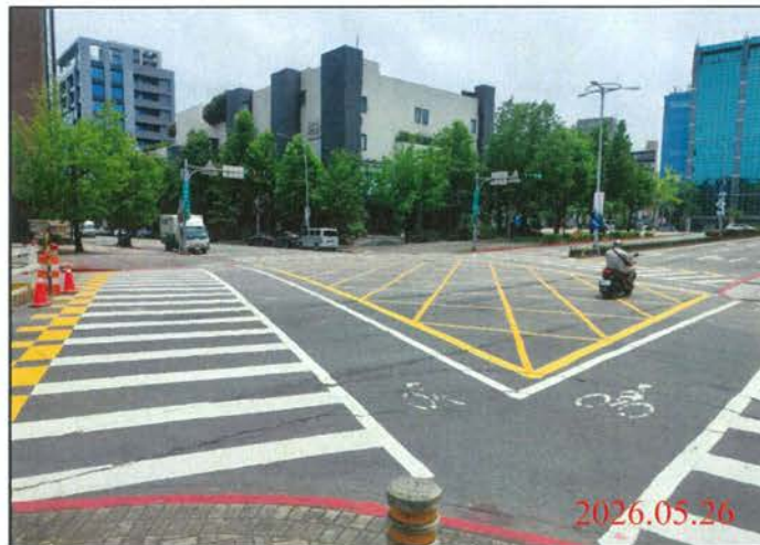
巡查日期地點：115.05.26/ Y30車站 照片說明：路面狀況
