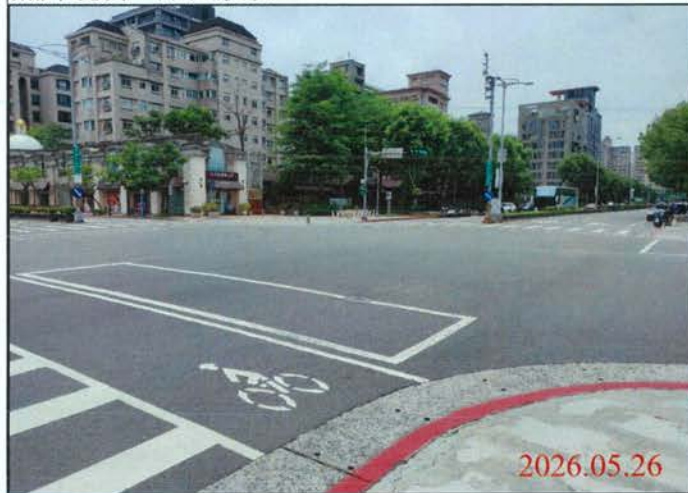
巡查日期地點：115.05.26/ 尾軌 照片說明：路面狀況
