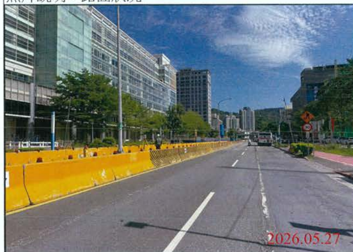
巡查日期地點：115.05.27/ 尾軌 照片說明：路面狀況
