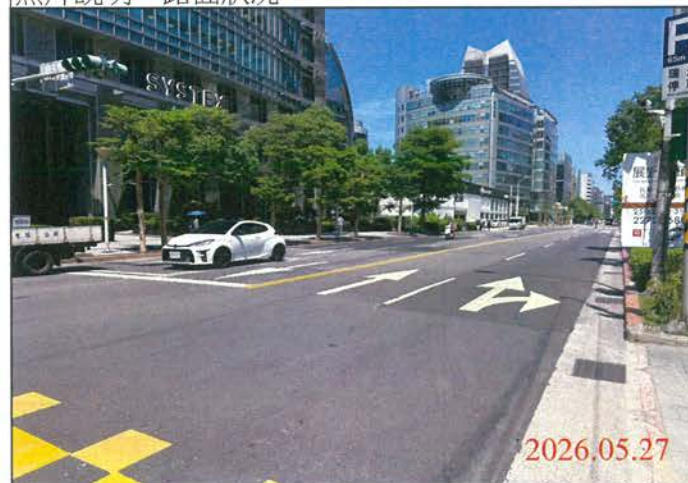
巡查日期地點：115.05.27/ Y32車站 照片說明：路面狀況
