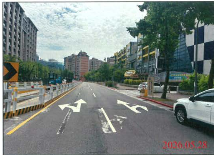
巡查日期地點：115.05.28/ Y30車站 照片說明：路面狀況
