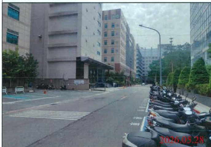
巡查日期地點：115.05.28/ Y31車站 照片說明：路面狀況
