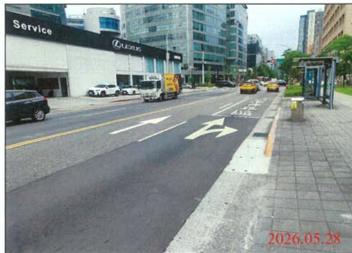
巡查日期地點：115.05.28/ Y32車站 照片說明：路面狀況
