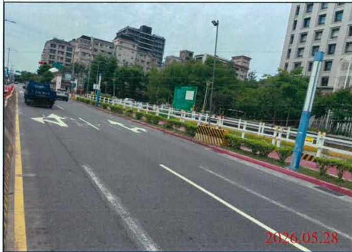
巡查日期地點：115.05.28/ 尾軌 照片說明：路面狀況
