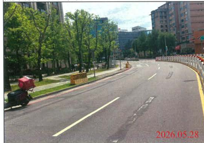
巡查日期地點：115.05.28/ Y30車站 照片說明：路面狀況
