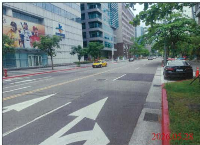
巡查日期地點：115.05.28/ Y31車站 照片說明：路面狀況
