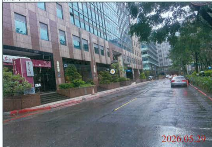
巡查日期地點：115.05.29/ Y31車站 照片說明：路面狀況
