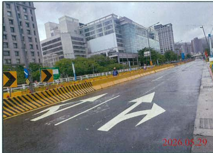
巡查日期地點：115.05.29/ 尾軌 照片說明：路面狀況
