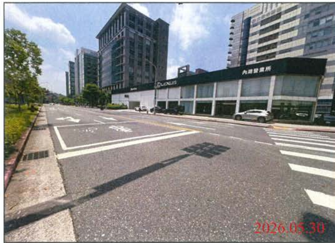
巡查日期地點：115.05.30/ Y32車站 照片說明：路面狀況
