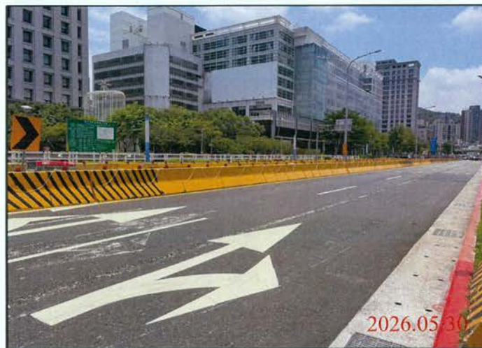
巡查日期地點：115.05.30/ 尾軌 照片說明：路面狀況
