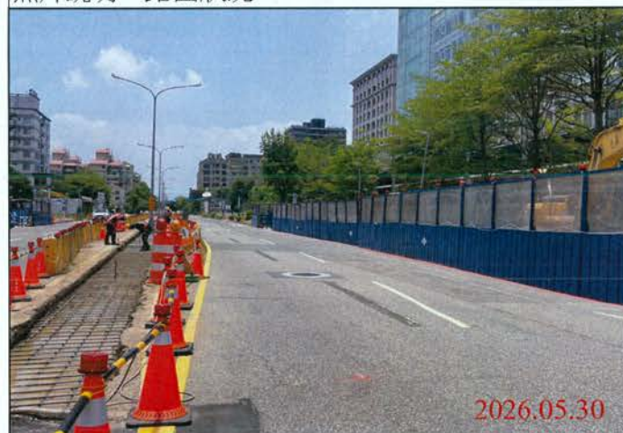
巡查日期地點：115.05.30/ 尾軌 照片說明：路面狀況
