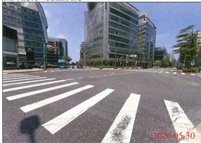
巡查日期地點：115.05.30/ Y32車站 照片說明：路面狀況
