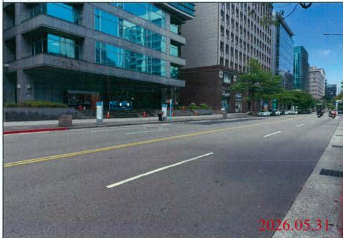
巡查日期地點：115.05.31/ Y31車站 照片說明：路面狀況
