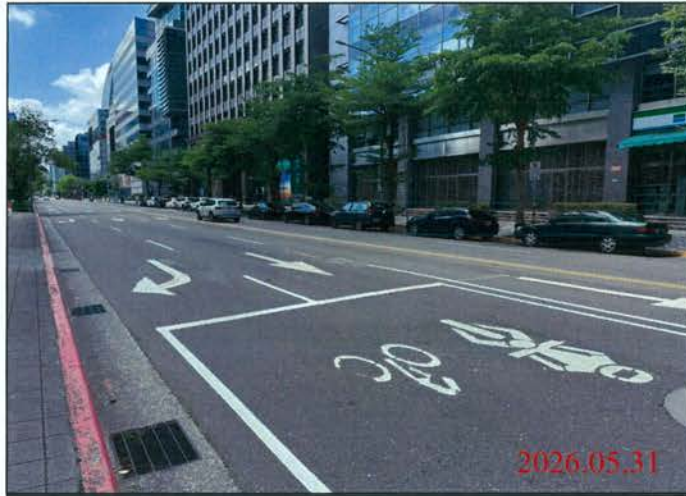
巡查日期地點：115.05.31/ Y31車站 照片說明：路面狀況
