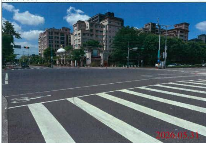
巡查日期地點：115.05.31/ 尾軌 照片說明：路面狀況
