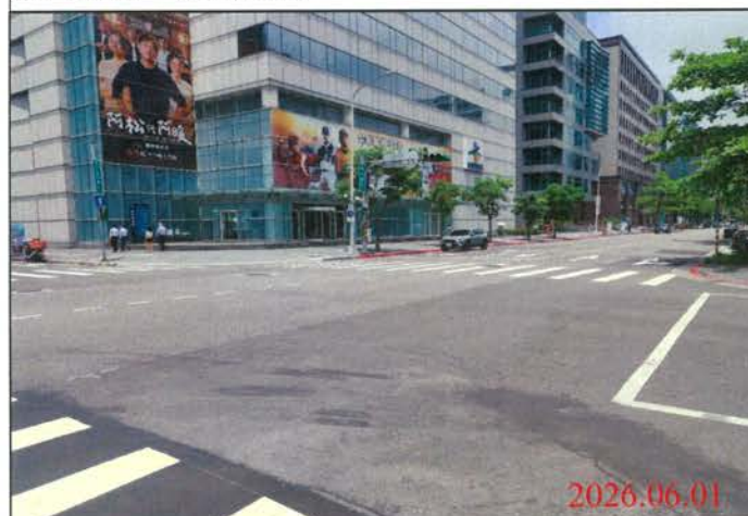
巡查日期地點：115.06.01/ Y31車站 照片說明：路面狀況
