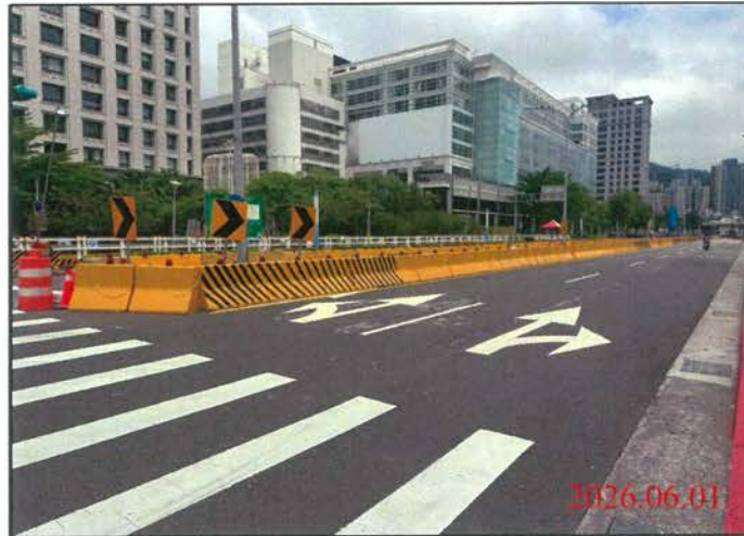
巡查日期地點：115.06.01/ 尾軌 照片說明：路面狀況
