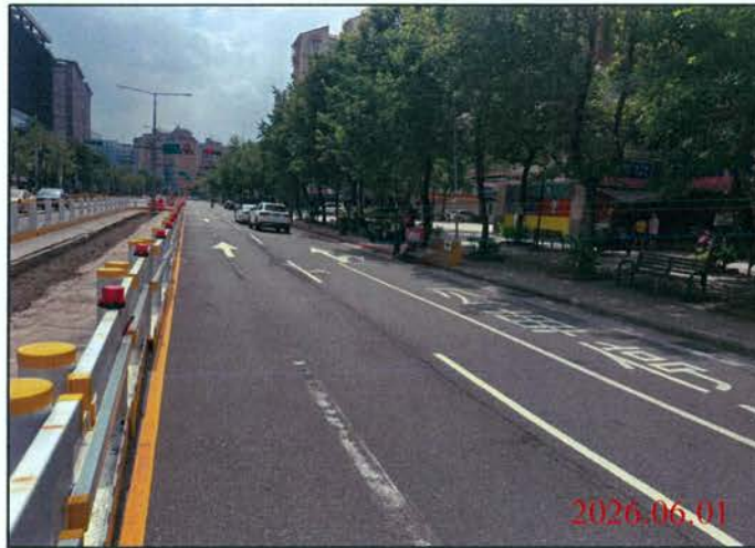
巡查日期地點：115.06.01/ Y30車站 照片說明：路面狀況
