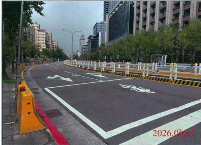
巡查日期地點：115.06.01/ Y30車站 照片說明：路面狀況
