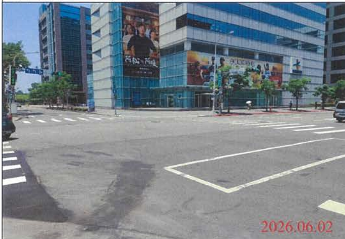
巡查日期地點：115.06.02/ Y31車站 照片說明：路面狀況
