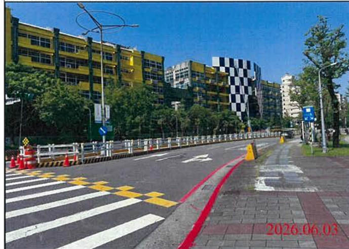
巡查日期地點：115.06.03/ Y30車站 照片說明：路面狀況
