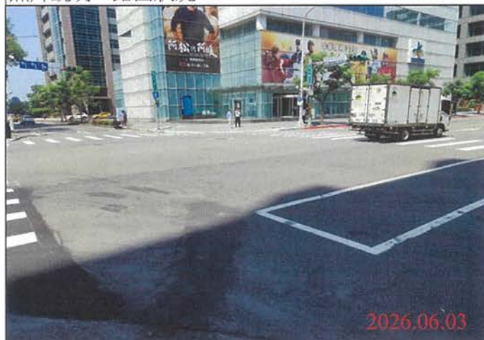
巡查日期地點：115.06.03/ Y31車站 照片說明：路面狀況
