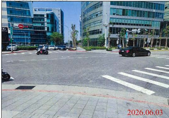
巡查日期地點：115.06.03/ Y32車站 照片說明：路面狀況
