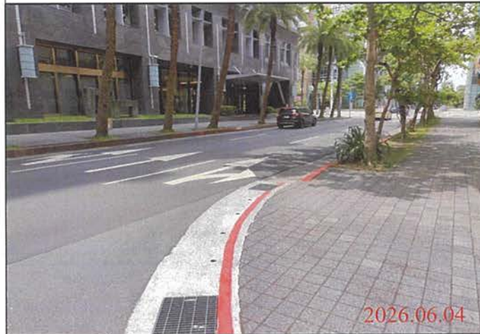
巡查日期地點：115.06.04/ Y31車站 照片說明：路面狀況
