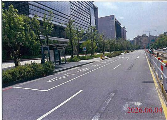
巡查日期地點：115.06.04/ Y30車站 照片說明：路面狀況
