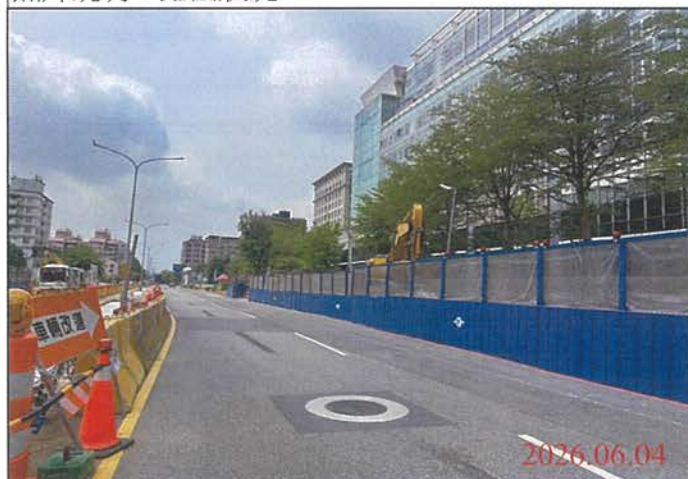
巡查日期地點：115.06.04/ 尾軌 照片說明：路面狀況
