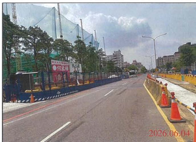
巡查日期地點：115.06.04/ 尾軌 照片說明：路面狀況
