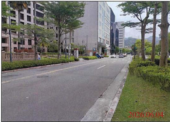
巡查日期地點：115.06.04/ Y32車站 照片說明：路面狀況
