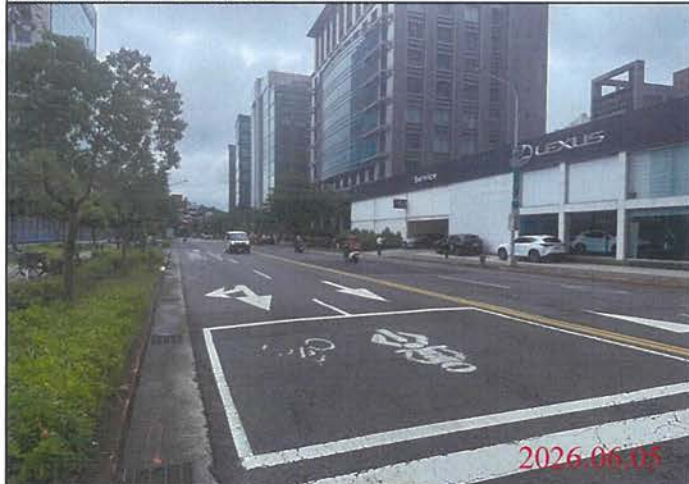
巡查日期地點：115.06.05/ Y32車站 照片說明：路面狀況
