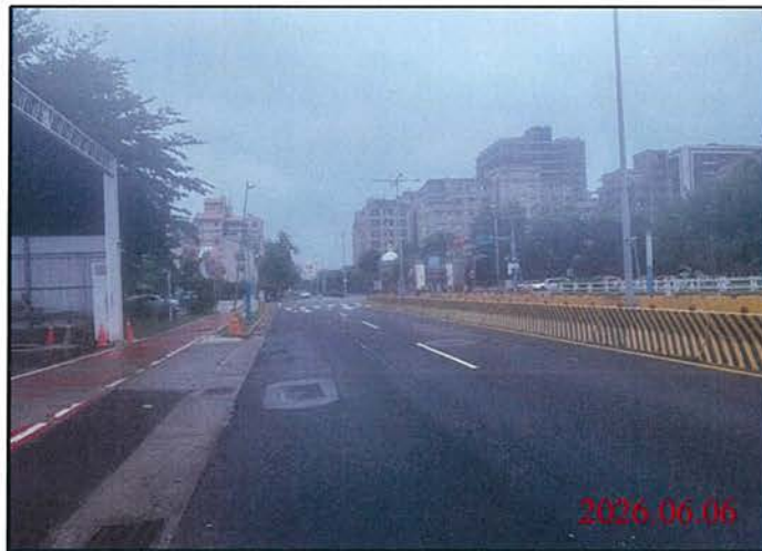
巡查日期地點：115.06.06/ 尾軌 照片說明：路面狀況
