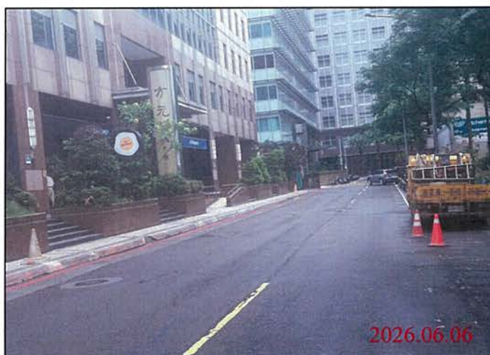
巡查日期地點：115.06.06/ Y31車站 照片說明：路面狀況
