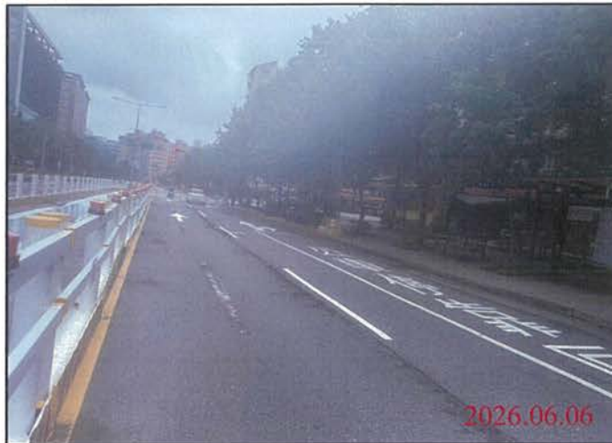
巡查日期地點：115.06.06/ Y30車站 照片說明：路面狀況
