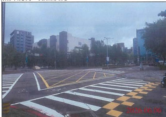
巡查日期地點：115.06.06/ Y30車站 照片說明：路面狀況
