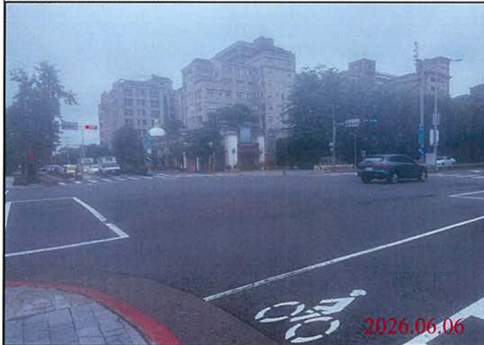
巡查日期地點：115.06.06/ 尾軌 照片說明：路面狀況
