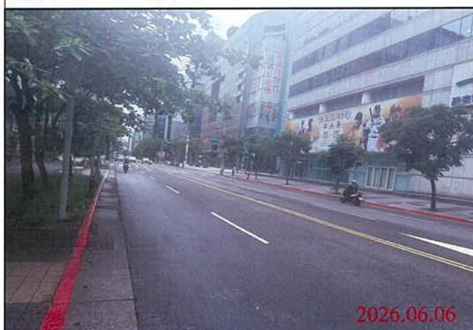
巡查日期地點：115.06.06/ Y31車站 照片說明：路面狀況
