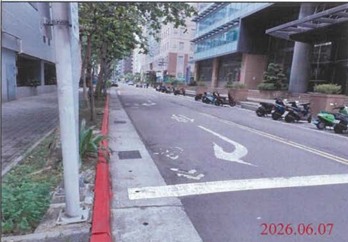
巡查日期地點：115.06.07/ Y31車站 照片說明：路面狀況
