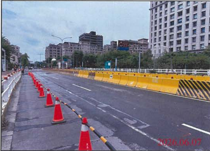
巡查日期地點：115.06.07/ 尾軌 照片說明：路面狀況
