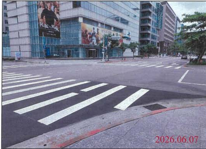
巡查日期地點：115.06.07/ Y31車站 照片說明：路面狀況
