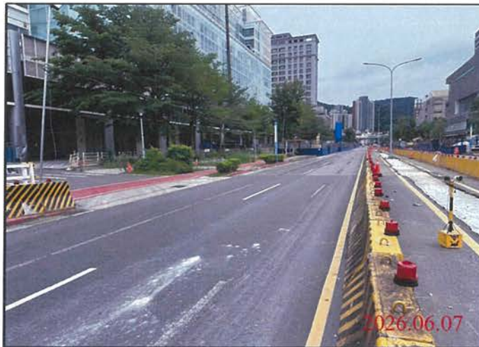
巡查日期地點：115.06.07/ 尾軌 照片說明：路面狀況
