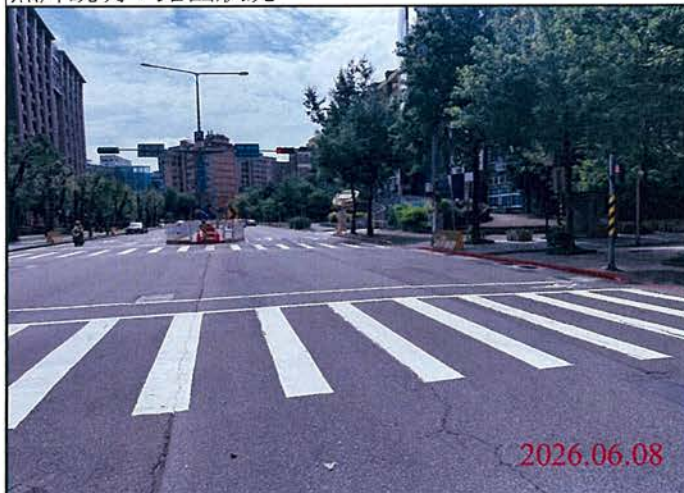
巡查日期地點：115.06.08/ Y30車站 照片說明：路面狀況
