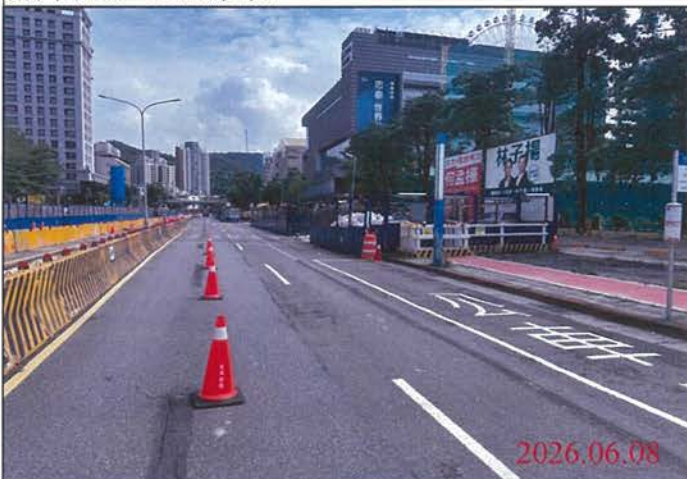
巡查日期地點：115.06.08/ 尾軌 照片說明：路面狀況
