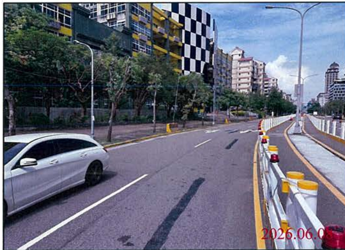
巡查日期地點：115.06.08/ Y30車站 照片說明：路面狀況
