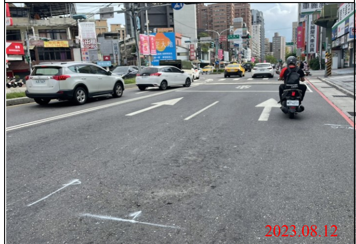
巡查日期地點：112.08.12/ Y21車站 照片說明：路面龜裂狀況
