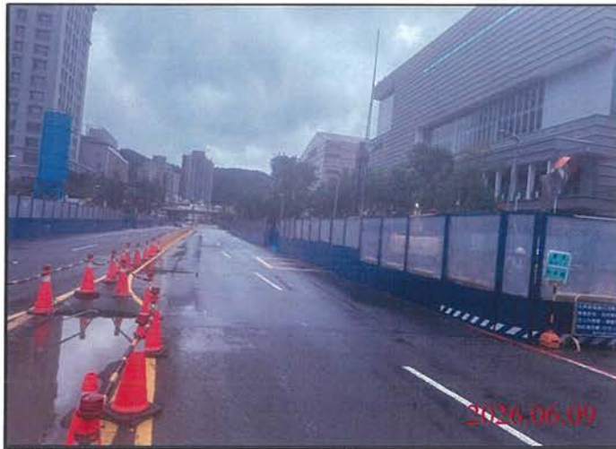
巡查日期地點：115.06.09/ 尾軌 照片說明：路面狀況
