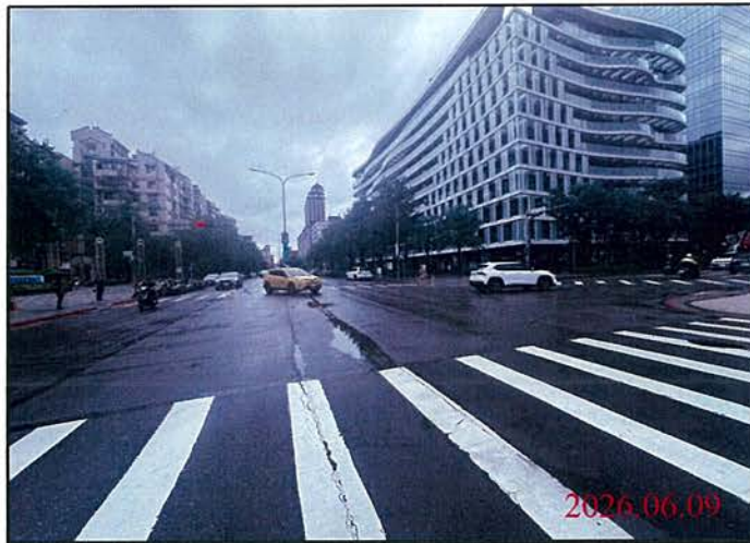
巡查日期地點：115.06.09/ Y30車站 照片說明：路面狀況
