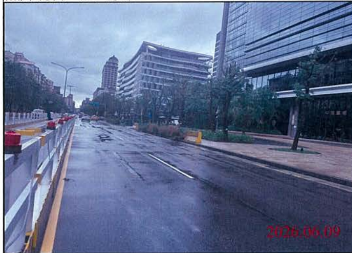
巡查日期地點：115.06.09/ Y30車站 照片說明：路面狀況
