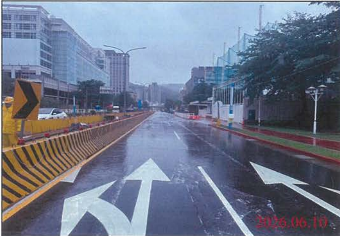
巡查日期地點：115.06.10/ 尾軌 照片說明：路面狀況
