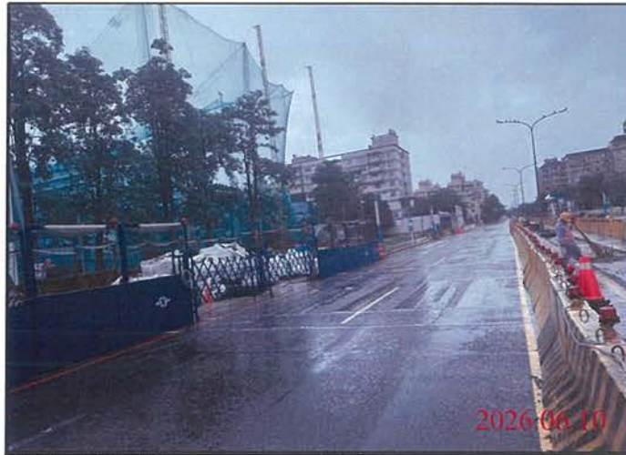
巡查日期地點：115.06.10/ 尾軌 照片說明：路面狀況
