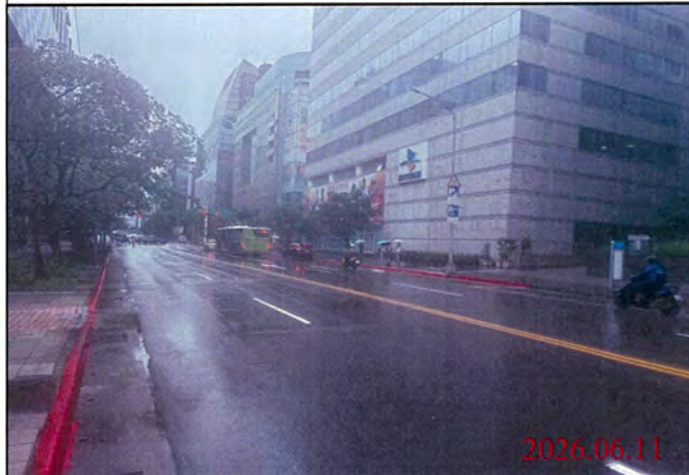
巡查日期地點：115.06.11/ Y31車站 照片說明：路面狀況
