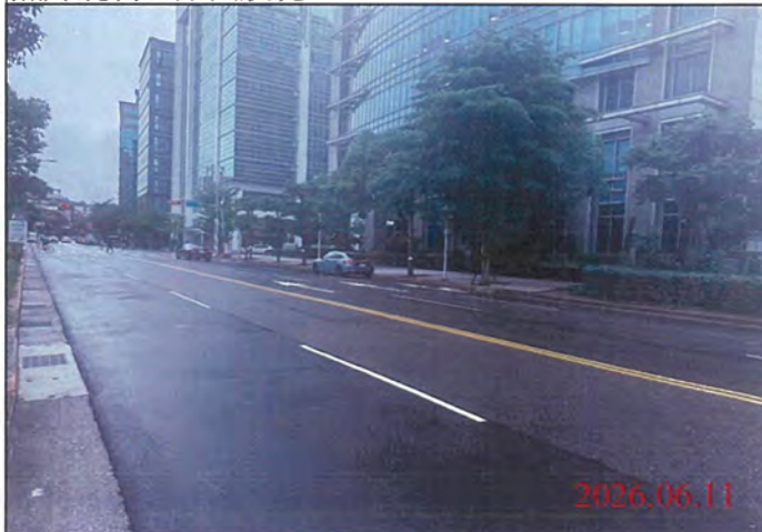
巡查日期地點：115.06.11/ Y32車站 照片說明：路面狀況
