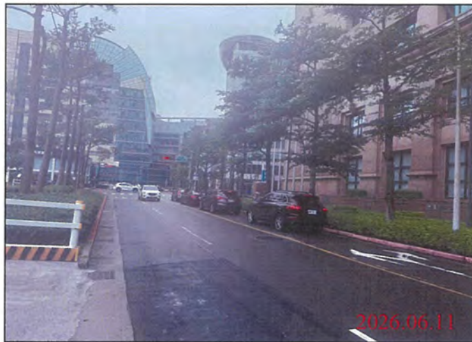
巡查日期地點：115.06.11/ Y32車站 照片說明：路面狀況
