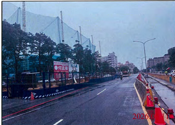
巡查日期地點：115.06.11/ 尾軌 照片說明：路面狀況
