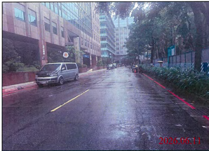
巡查日期地點：115.06.11/ Y31車站 照片說明：路面狀況
