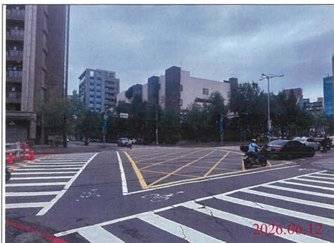
巡查日期地點：115.06.12/ Y30車站 照片說明：路面狀況
