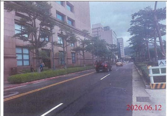
巡查日期地點：115.06.12/ Y32車站 照片說明：路面狀況
