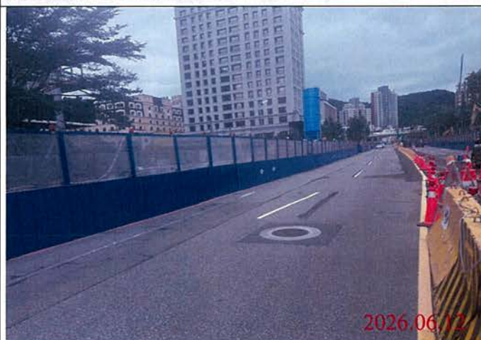
巡查日期地點：115.06.12/ 尾軌 照片說明：路面狀況
