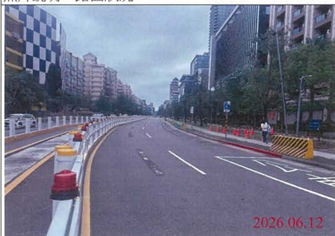
巡查日期地點：115.06.11/ Y30車站 照片說明：路面狀況
