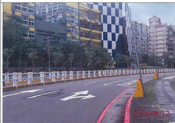
巡查日期地點：115.06.12/ Y30車站 照片說明：路面狀況
