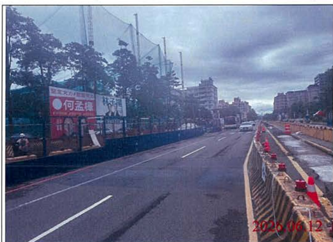
巡查日期地點：115.06.12/ 尾軌 照片說明：路面狀況
