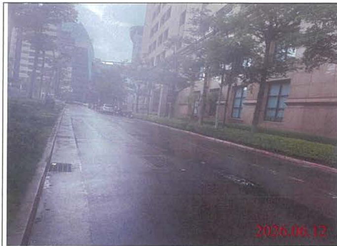
巡查日期地點：115.06.12/ Y32車站 照片說明：路面狀況
