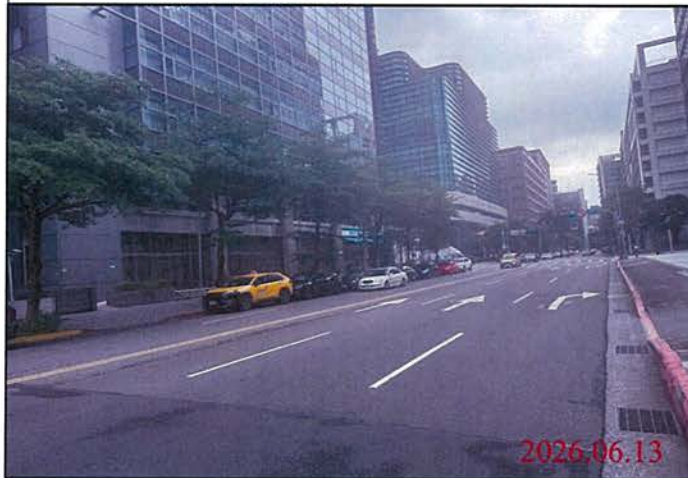
巡查日期地點：115.06.13/ Y31車站 照片說明：路面狀況
