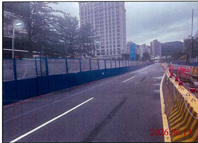
巡查日期地點：115.06.13/ 尾軌 照片說明：路面狀況
