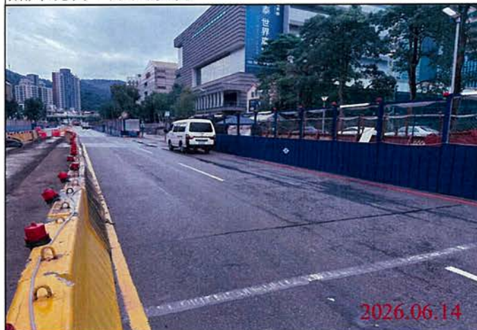
巡查日期地點：115.06.14/ 尾軌 照片說明：路面狀況
