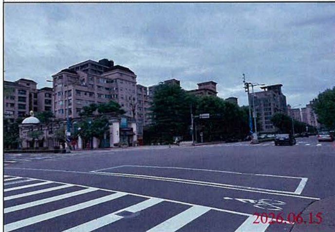
巡查日期地點：115.06.15/ 尾軌 照片說明：路面狀況
