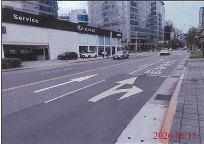
巡查日期地點：115.06.15/ Y32車站 照片說明：路面狀況
