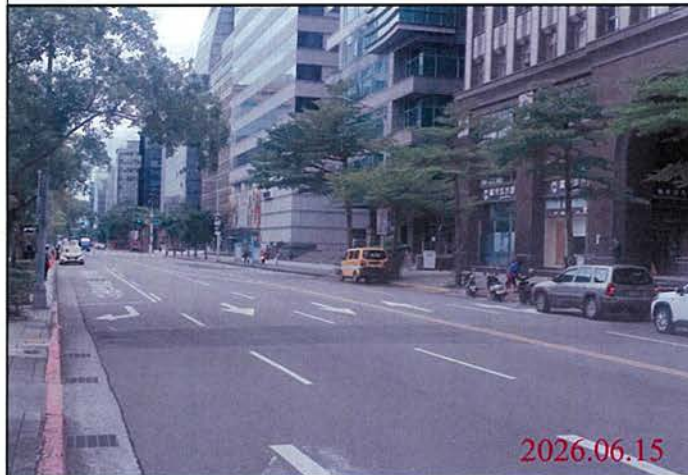
巡查日期地點：115.06.15/ Y31車站 照片說明：路面狀況
