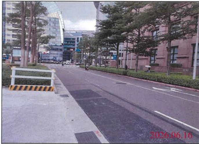
巡查日期地點：115.06.16/ Y32車站 照片說明：路面狀況
