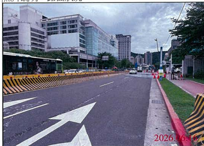
巡查日期地點：115.06.16/ 尾軌 照片說明：路面狀況
