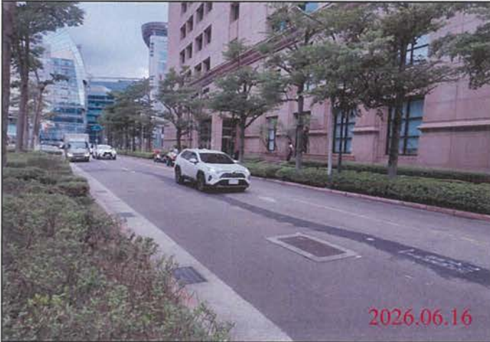
巡查日期地點：115.06.16/ Y32車站 照片說明：路面狀況
