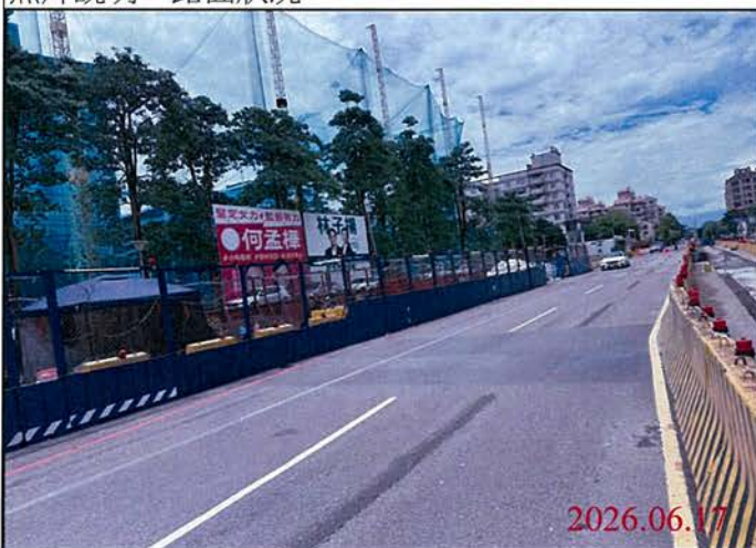
巡查日期地點：115.06.17/ 尾軌 照片說明：路面狀況
