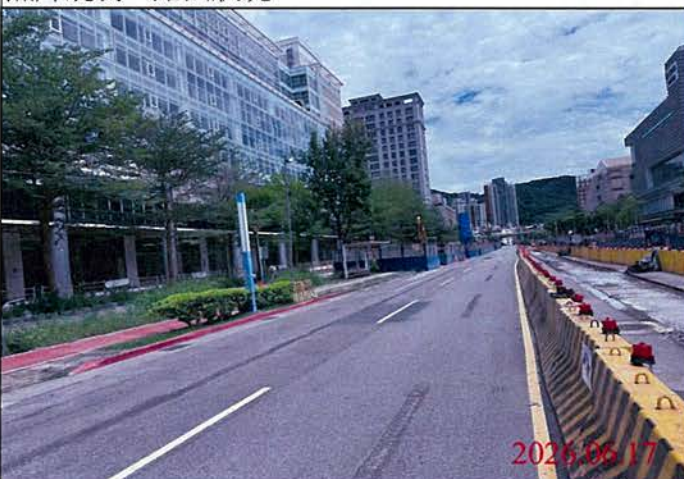
巡查日期地點：115.06.17/ 尾軌 照片說明：路面狀況
