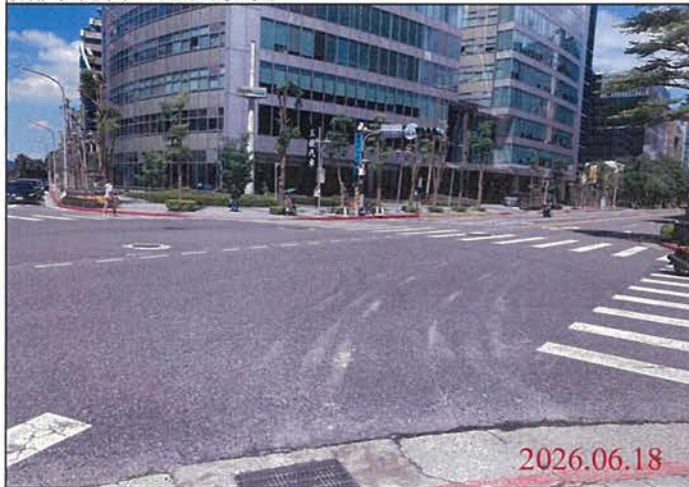
巡查日期地點：115.06.18/ Y32車站 照片說明：路面狀況
