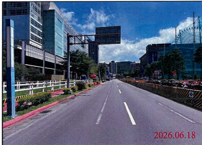
巡查日期地點：115.06.18/ 尾軌 照片說明：路面狀況
