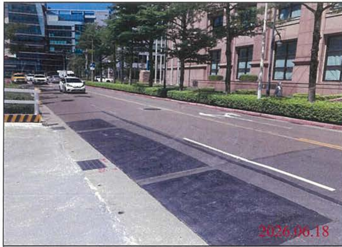
巡查日期地點：115.06.18/ Y32車站 照片說明：路面狀況
