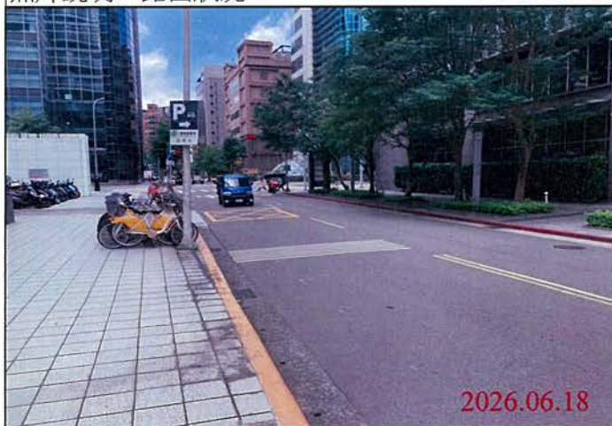
巡查日期地點：115.06.18/ Y31車站 照片說明：路面狀況
