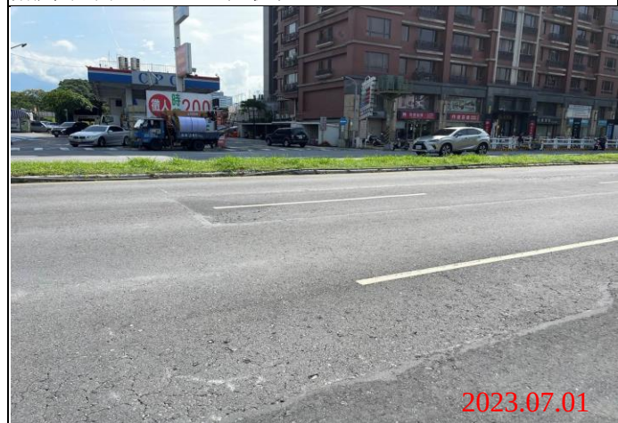
巡查日期地點：112.07.01/ Y23車站 照片說明：路面龜裂狀況
