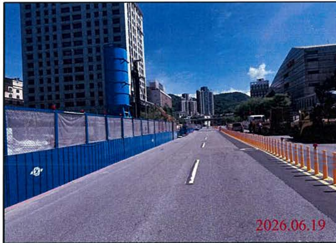
巡查日期地點：115.06.19/ 尾軌 照片說明：路面狀況
