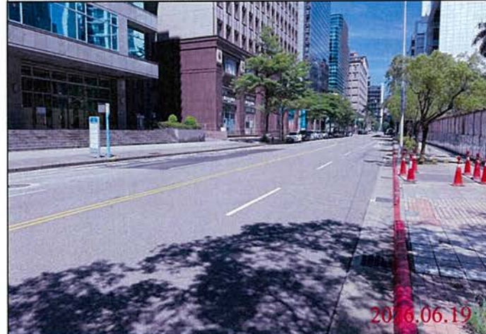
巡查日期地點：115.06.19/ Y31車站 照片說明：路面狀況
