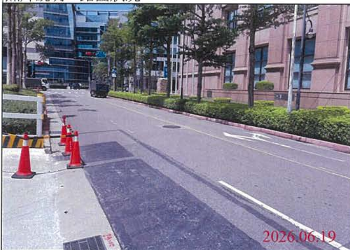
巡查日期地點：115.06.19/ Y32車站 照片說明：路面狀況
