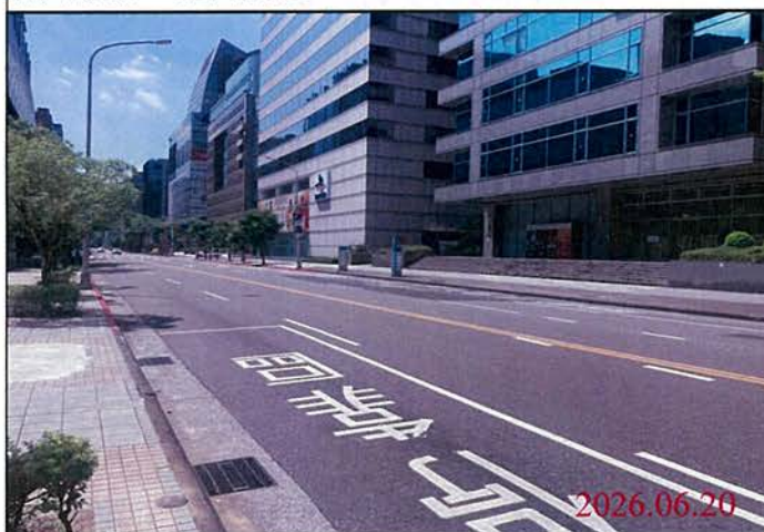
巡查日期地點：115.06.20/ Y31車站 照片說明：路面狀況
