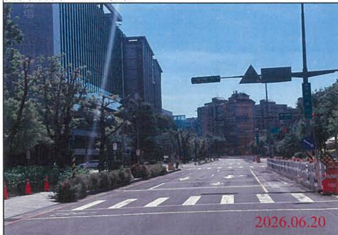
巡查日期地點：115.06.20/ Y30車站 照片說明：路面狀況
