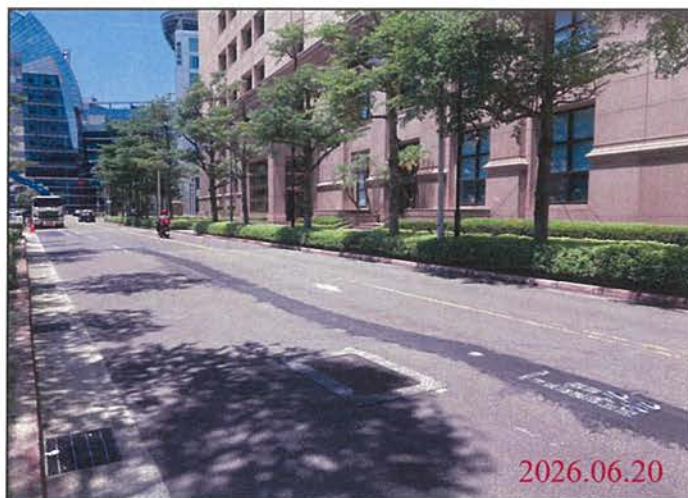
巡查日期地點：115.06.20/ Y32車站 照片說明：路面狀況
