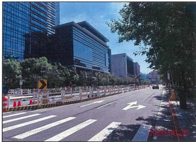
巡查日期地點：115.06.20/ Y30車站 照片說明：路面狀況
