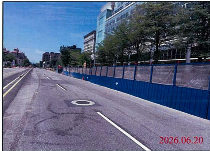
巡查日期地點：115.06.20/ 尾軌 照片說明：路面狀況
