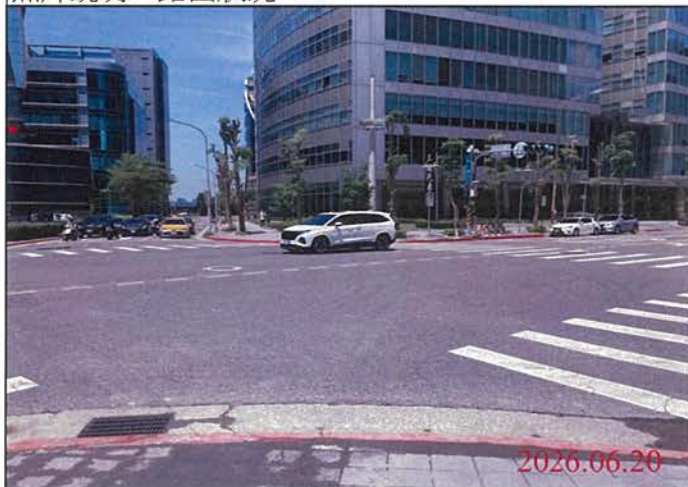
巡查日期地點：115.06.20/ Y32車站 照片說明：路面狀況
