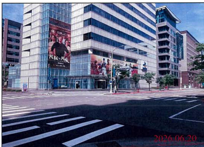
巡查日期地點：115.06.20/ Y31車站 照片說明：路面狀況
