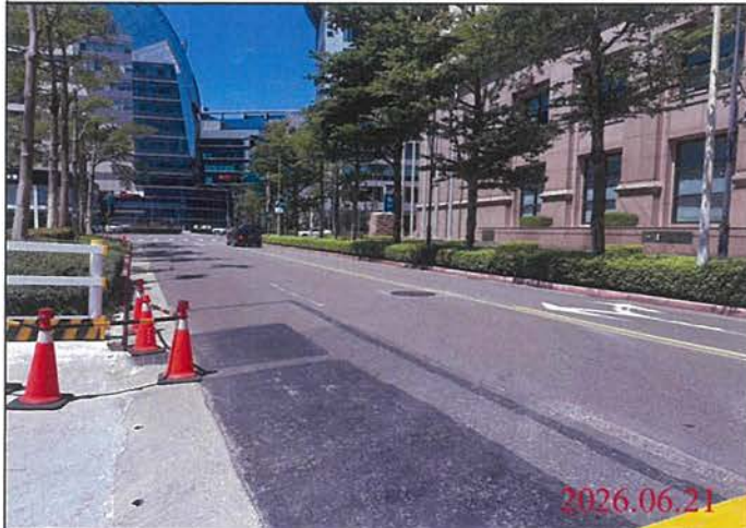
巡查日期地點：115.06.21/ Y32車站 照片說明：路面狀況
