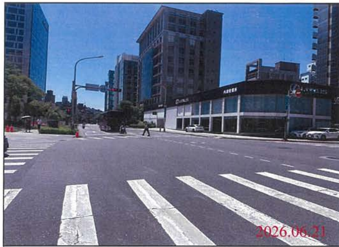
巡查日期地點：115.06.21/ Y32車站 照片說明：路面狀況
