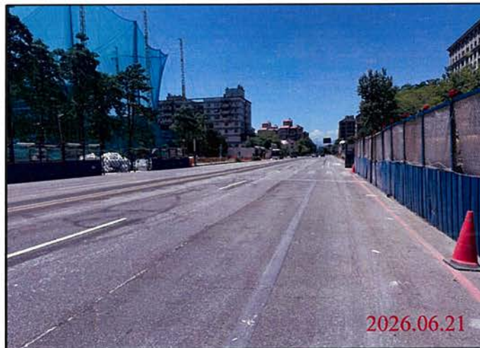
巡查日期地點：115.06.21/ 尾軌 照片說明：路面狀況
