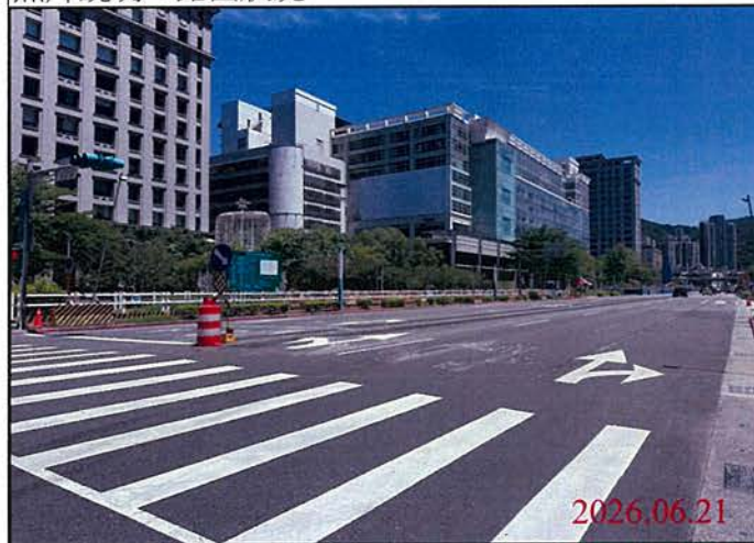
巡查日期地點：115.06.21/ 尾軌 照片說明：路面狀況
