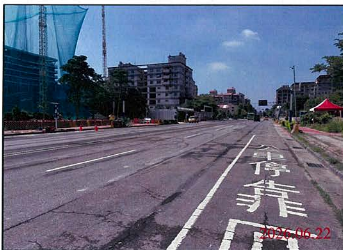
巡查日期地點：115.06.22/ 尾軌 照片說明：路面狀況
