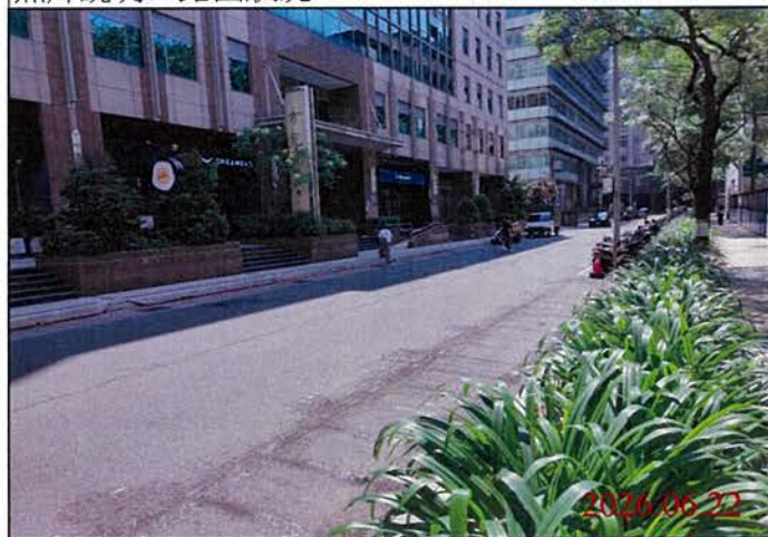
巡查日期地點：115.06.22/ Y31車站 照片說明：路面狀況
