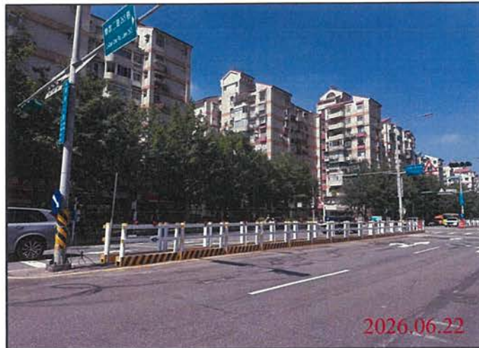
巡查日期地點：115.06.22/ Y30車站 照片說明：路面狀況
