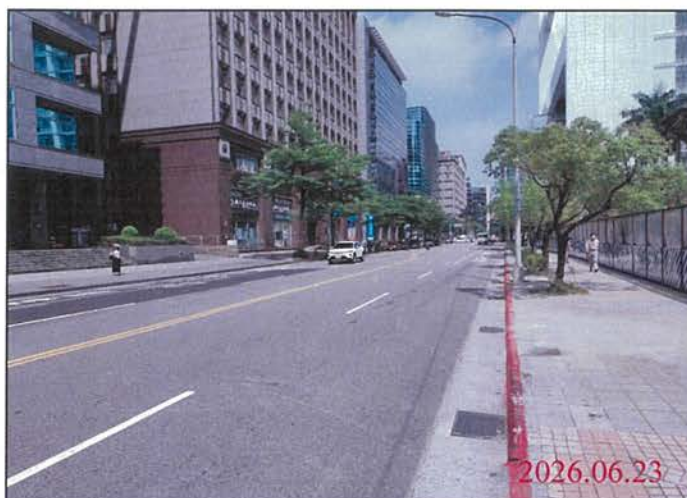
巡查日期地點：115.06.23/ Y31車站 照片說明：路面狀況
