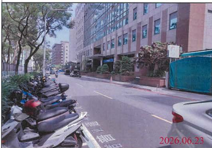
巡查日期地點：115.06.23/ Y31車站 照片說明：路面狀況
