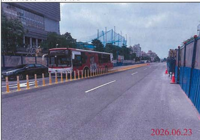
巡查日期地點：115.06.23/ 尾軌 照片說明：路面狀況
