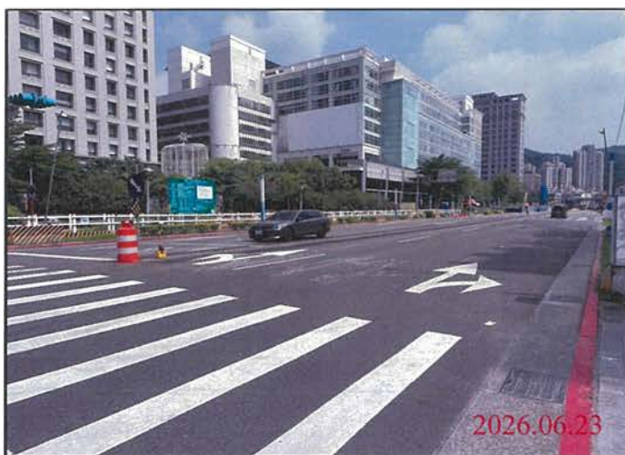
巡查日期地點：115.06.23/ 尾軌 照片說明：路面狀況
