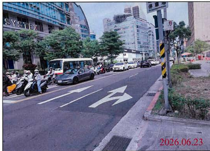
巡查日期地點：115.06.23/ Y32車站 照片說明：路面狀況
