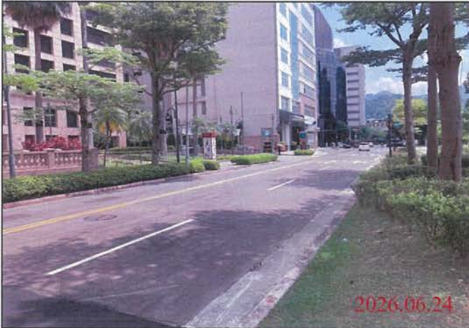
巡查日期地點：115.06.24/ Y32車站 照片說明：路面狀況
