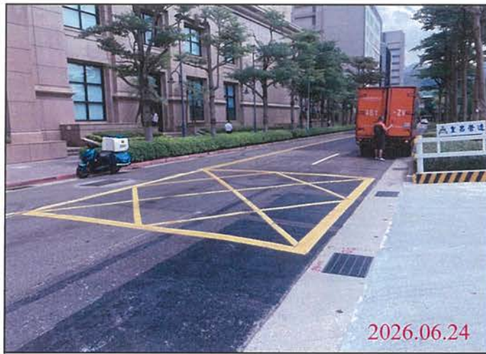
巡查日期地點：115.06.24/ Y32車站 照片說明：路面狀況
