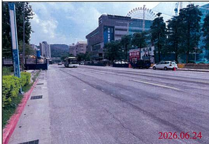
巡查日期地點：115.06.24/ 尾軌 照片說明：路面狀況
