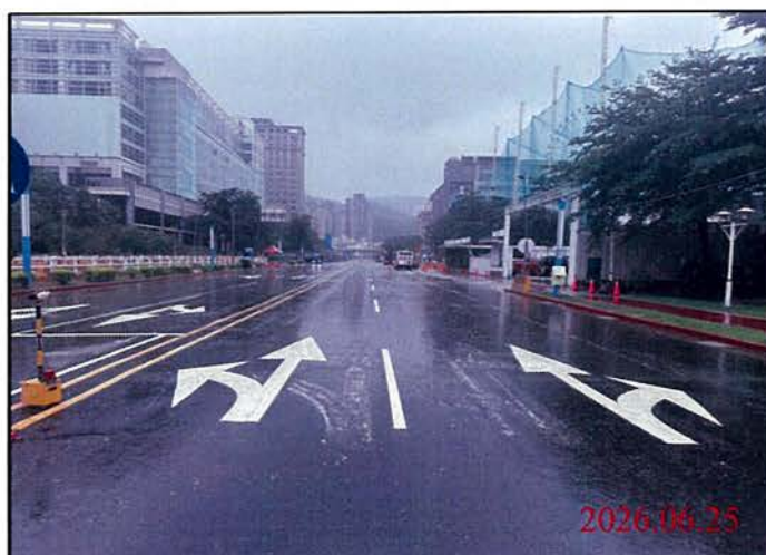
巡查日期地點：115.06.25/ 尾軌 照片說明：路面狀況
