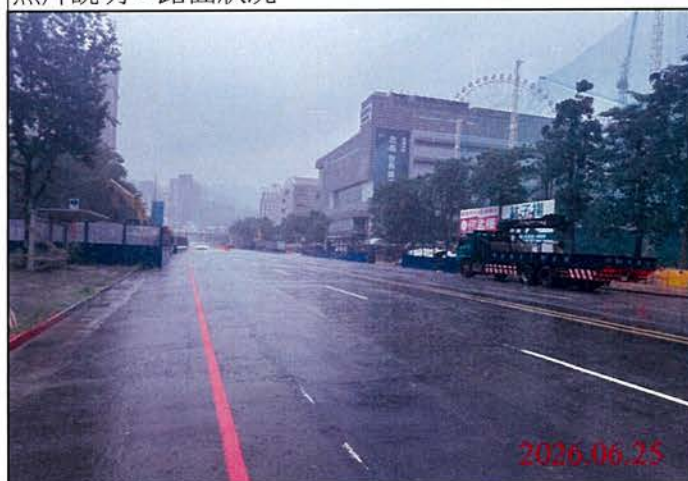
巡查日期地點：115.06.25/ 尾軌 照片說明：路面狀況
