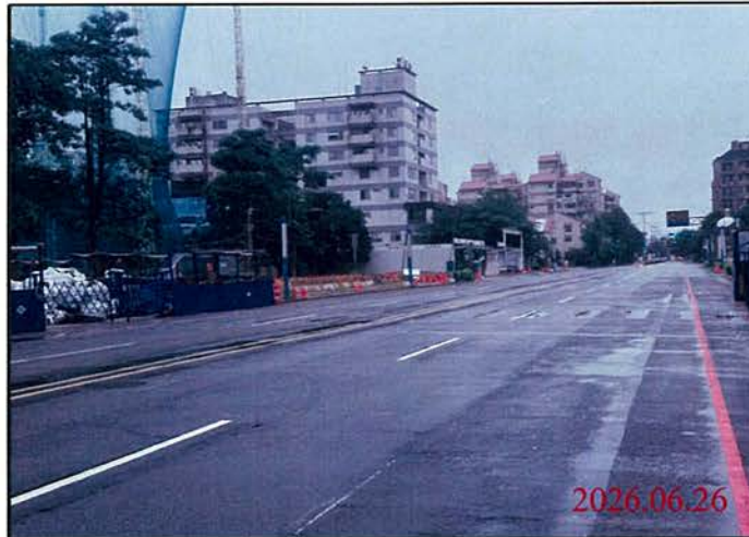
巡查日期地點：115.06.26/ 尾軌 照片說明：路面狀況
