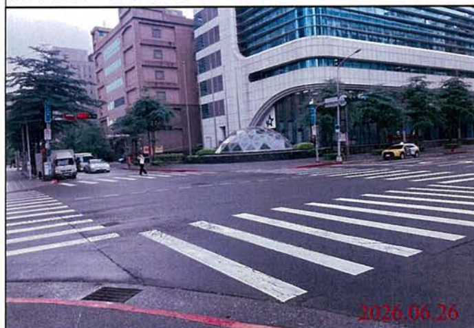
巡查日期地點：115.06.26/ Y31車站 照片說明：路面狀況
