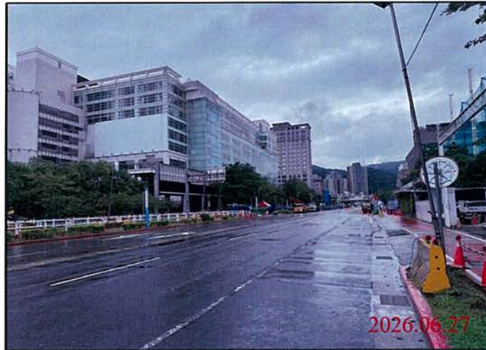
巡查日期地點：115.06.27/ 尾軌 照片說明：路面狀況
