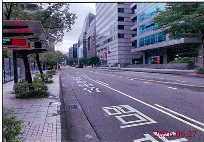
巡查日期地點：115.06.27/ Y31車站 照片說明：路面狀況
