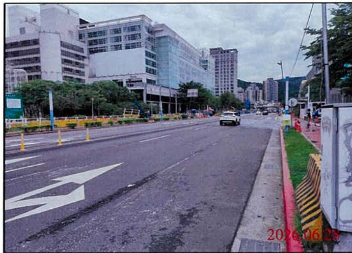
巡查日期地點：115.06.28/ 尾軌 照片說明：路面狀況
