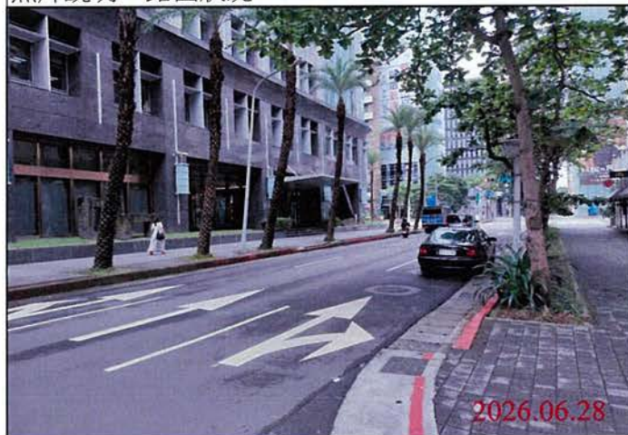
巡查日期地點：115.06.28/ Y31車站 照片說明：路面狀況
