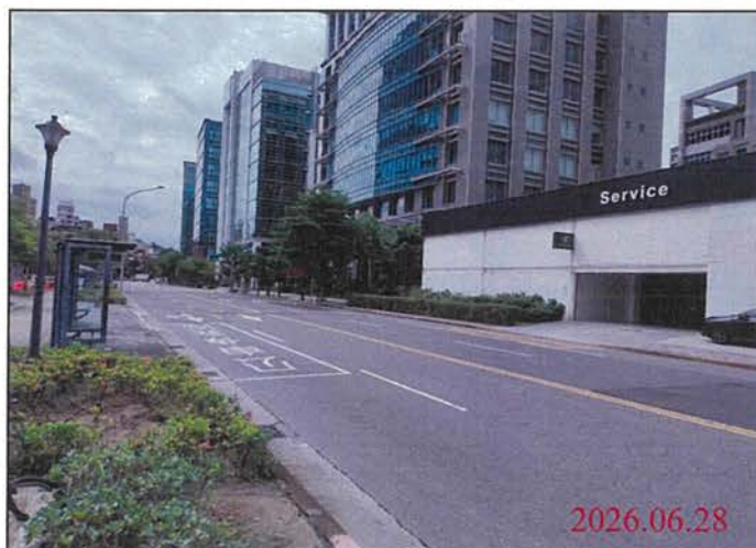
巡查日期地點：115.06.28/ Y32車站 照片說明：路面狀況
