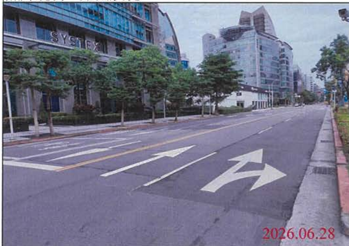
巡查日期地點：115.06.28/ Y32車站 照片說明：路面狀況
