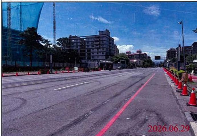
巡查日期地點：115.06.29/ 尾軌 照片說明：路面狀況
