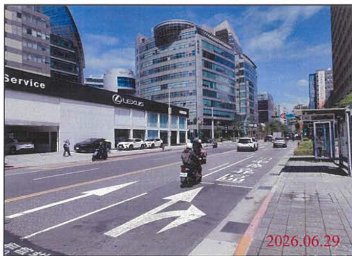
巡查日期地點：115.06.29/ Y32車站 照片說明：路面狀況
