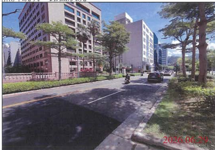
巡查日期地點：115.06.29/ Y32車站 照片說明：路面狀況
