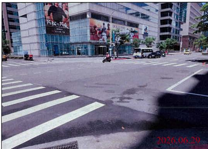
巡查日期地點：115.06.29/ Y31車站 照片說明：路面狀況
