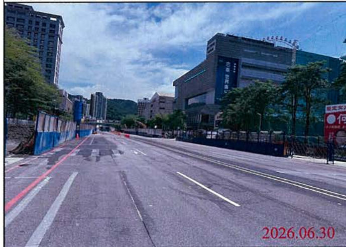
巡查日期地點：115.06.30/ 尾軌 照片說明：路面狀況
