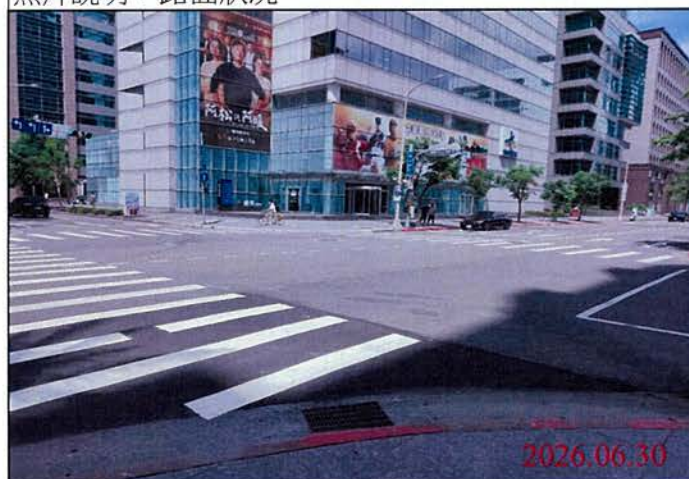
巡查日期地點：115.06.30/ Y31車站 照片說明：路面狀況
