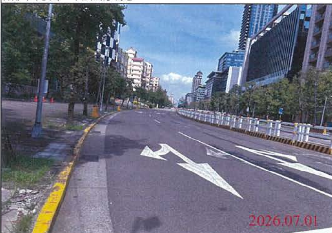
巡查日期地點：115.07.01/ Y30車站 照片說明：路面狀況
