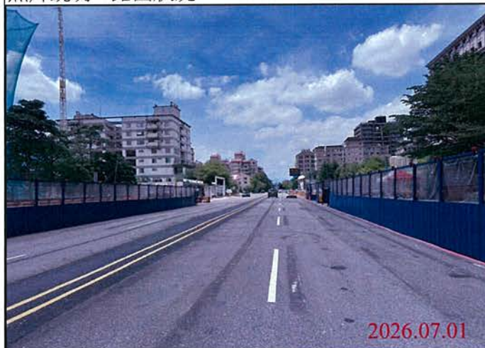
巡查日期地點：115.07.01/ 尾軌 照片說明：路面狀況
