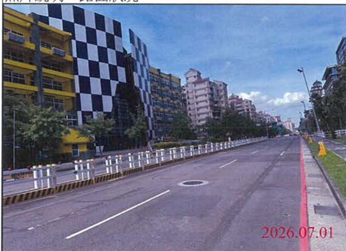
巡查日期地點：115.07.01/ Y30車站 照片說明：路面狀況
