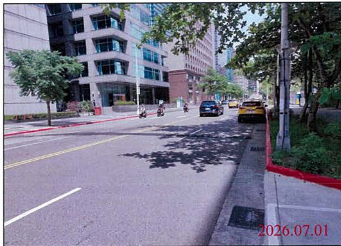
巡查日期地點：115.07.01/ Y31車站 照片說明：路面狀況
