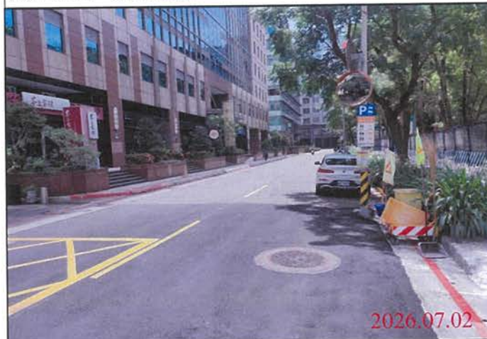
巡查日期地點：115.07.02/ Y31車站 照片說明：路面狀況
