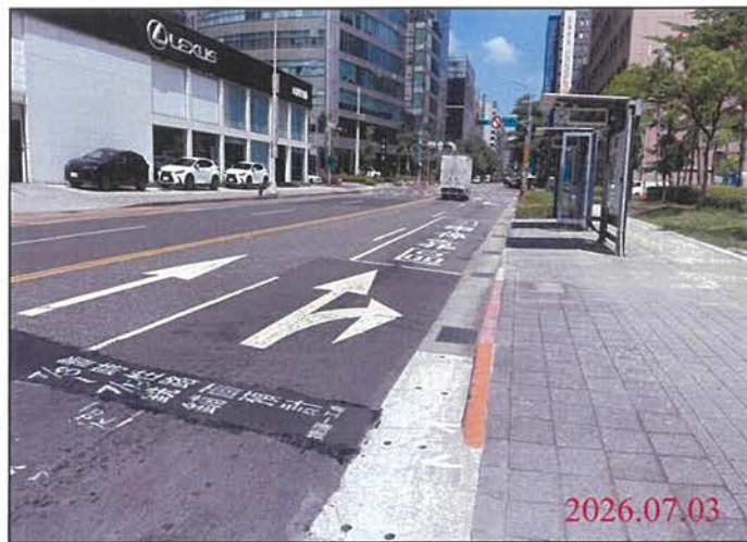
巡查日期地點：115.07.03/ Y32車站 照片說明：路面狀況
