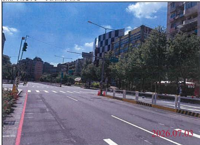
巡查日期地點：115.07.03/ Y30車站 照片說明：路面狀況
