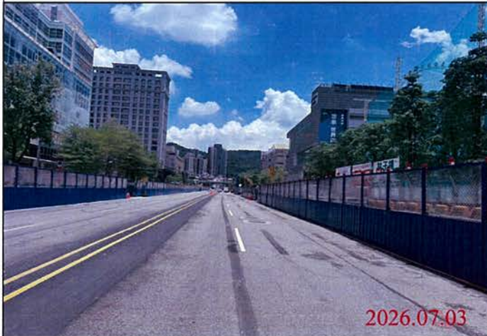
巡查日期地點：115.07.03/ 尾軌 照片說明：路面狀況
