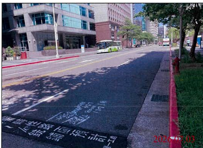
巡查日期地點：115.07.03/ Y31車站 照片說明：路面狀況
