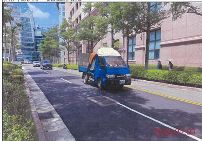
巡查日期地點：115.07.03/ Y32車站 照片說明：路面狀況
