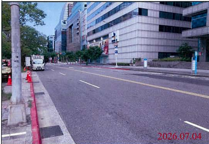
巡查日期地點：115.07.04/ Y31車站 照片說明：路面狀況
