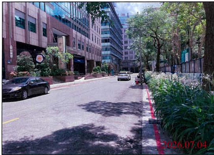
巡查日期地點：115.07.04/ Y31車站 照片說明：路面狀況
