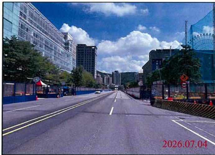
巡查日期地點：115.07.04/ 尾軌 照片說明：路面狀況
