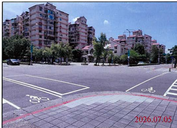
巡查日期地點：115.07.05 尾軌 照片說明：路面狀況
