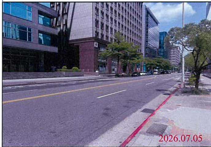
巡查日期地點：115.07.05 Y31車站 照片說明：路面狀況
