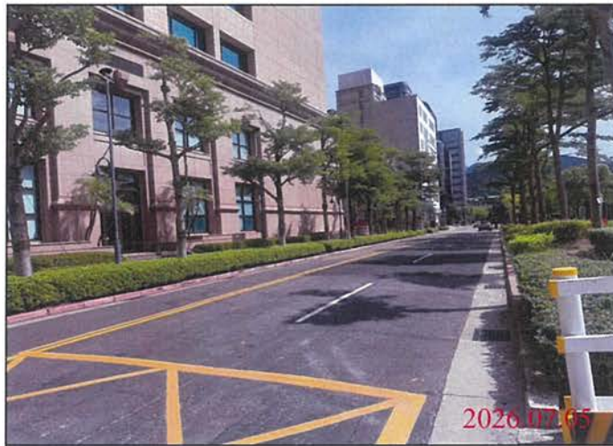
巡查日期地點：115.07.05 Y32車站 照片說明：路面狀況
