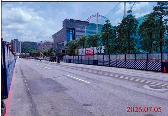
巡查日期地點：115.07.05 尾軌 照片說明：路面狀況
