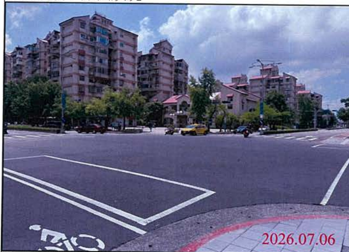
巡查日期地點：115.07.06 尾軌 照片說明：路面狀況
