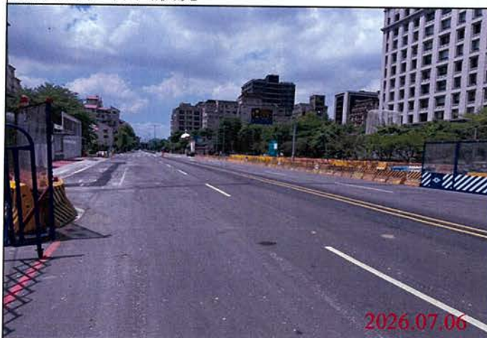
巡查日期地點：115.07.06 尾軌 照片說明：路面狀況
