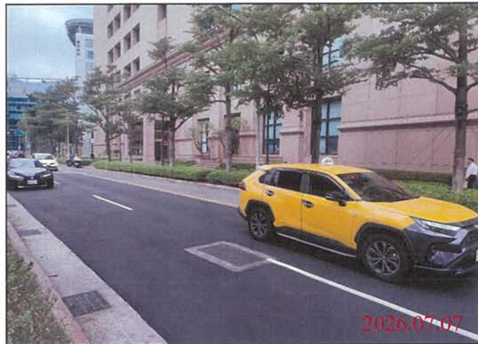
巡查日期地點：115.07.07 Y32車站 照片說明：路面狀況
