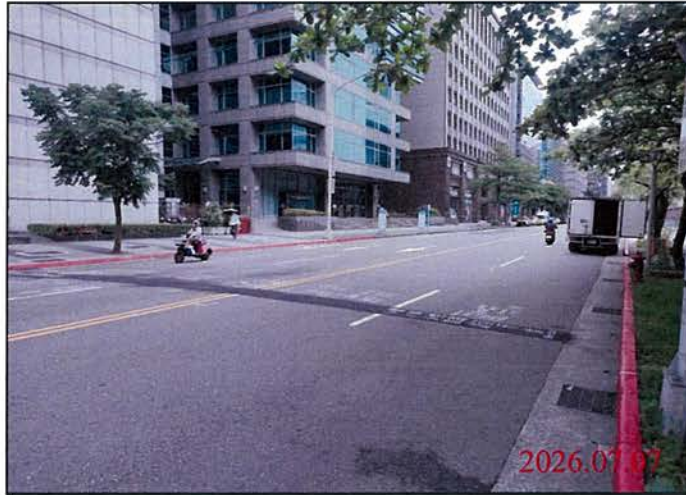
巡查日期地點：115.07.07 Y31車站 照片說明：路面狀況
