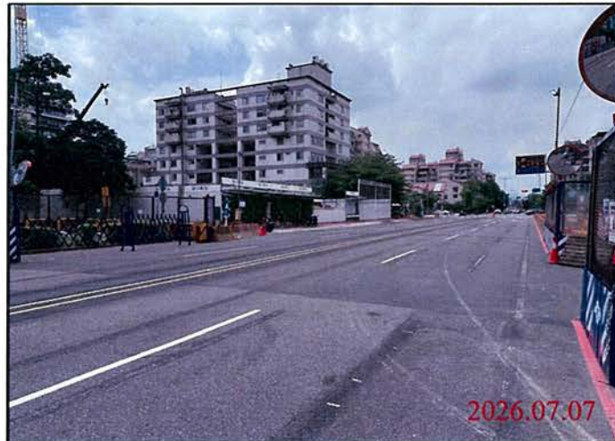
巡查日期地點：115.07.07 尾軌 照片說明：路面狀況
