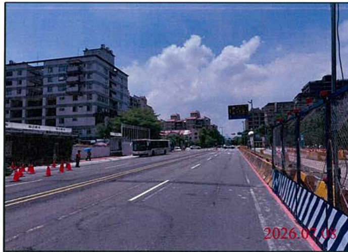
巡查日期地點：115.07.08 尾軌 照片說明：路面狀況
