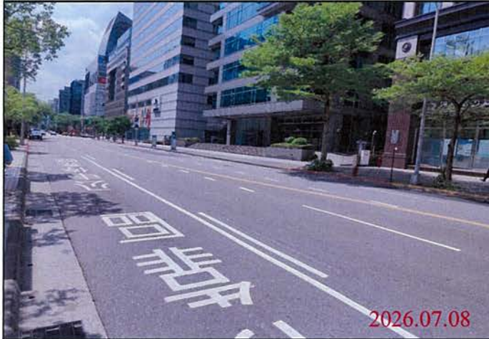
巡查日期地點：115.07.08 Y31車站 照片說明：路面狀況
