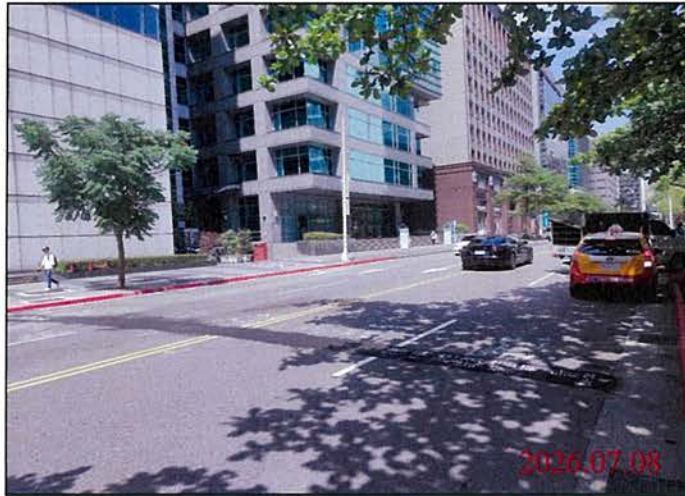
巡查日期地點：115.07.08 Y31車站 照片說明：路面狀況
