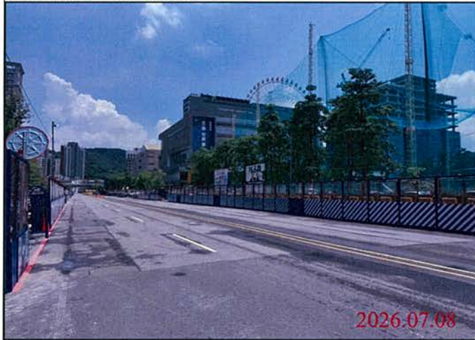
巡查日期地點：115.07.08 尾軌 照片說明：路面狀況
