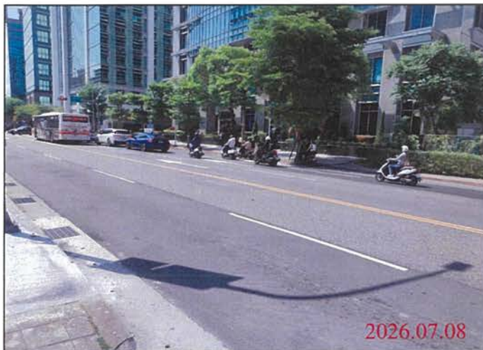
巡查日期地點：115.07.08 Y32車站 照片說明：路面狀況
